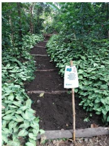
Foto 91 - Barreiras de contenção para quebra da velocidade da água e controle dos processos erosivos (tempo 2)
