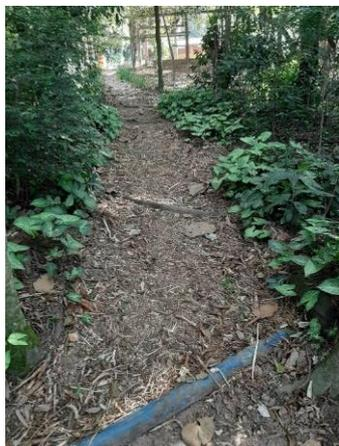
Foto 89 - Restrução da trilha com a colocação de material triturado e instalação de bambus no sentido transversal do sistema de drenagem
